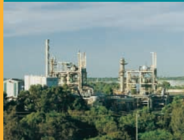
Sodium Cyanide plant, Kwinana.
